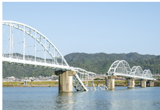
六十谷水管橋の崩落事故(国土交通省ウェブサイトより)
