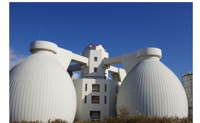
汚泥処理センターの卵型汚泥消化タンク
