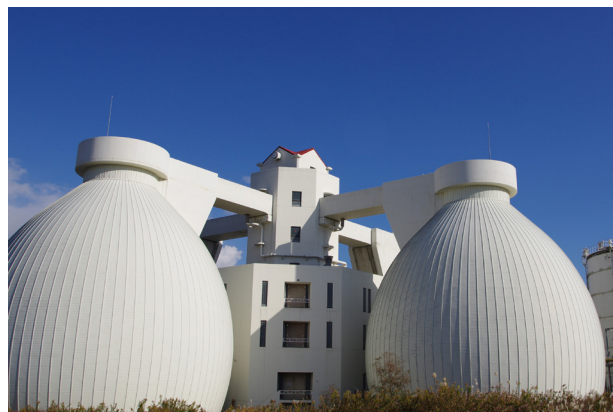
汚泥処理センターの卵型汚泥消化タンク
