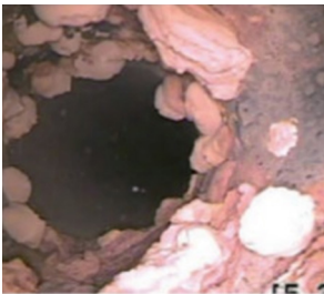
老朽化が進む管路施設 錆が発生している水道管(左)と地下水が浸入する下水道管(右)
