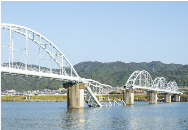
六十谷水管橋の崩落事故(国土交通省ウェブサイトより)
