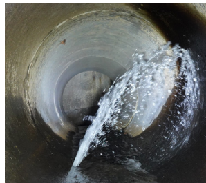
老朽化が進む管路施設 錆が発生している水道管(左)と地下水が浸入する下水道管(右)
