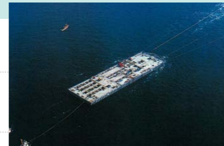
鋼殻ケーソン下水処理場の曳航
