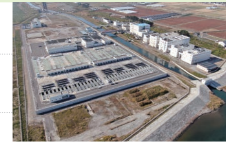
仙台市南蒲浄化センター（復旧後）
