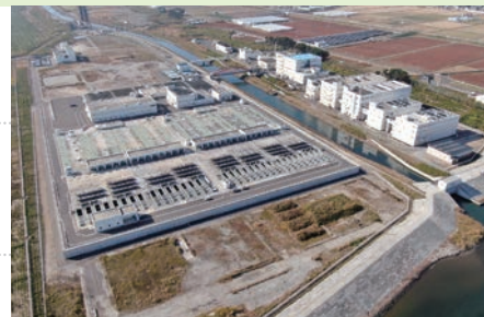
仙台市南蒲生浄化センター（復旧後）
