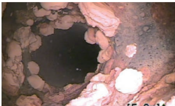
老朽化が進む管路施設：錆が発生している水道管（左）、地下水が浸入する下水道管（右）
