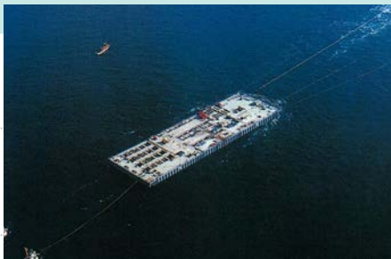
鋼殻ケーソン下水処理場の曳航
