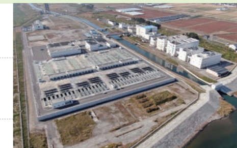
仙台市南蒲浄化センター（復旧後）
