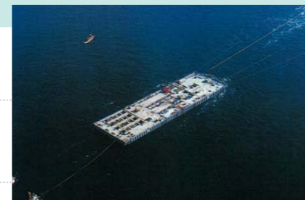
鋼殻ケーソン下水処理場の曳航
