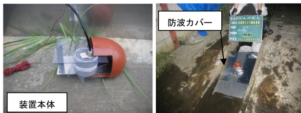
図-3 管内発電装置の設置状況
