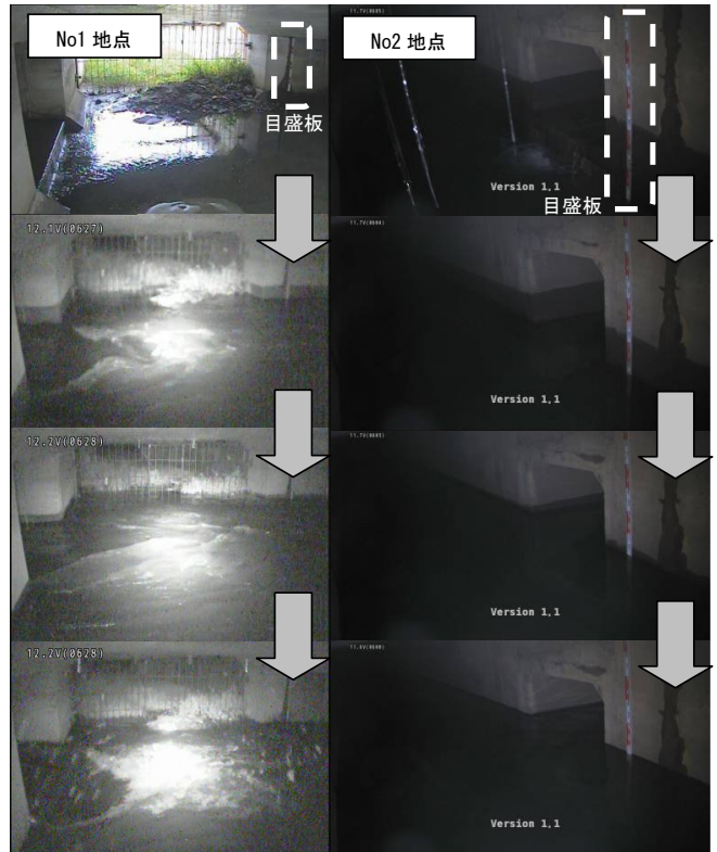
図-4 雨天時の管路内状況写真
