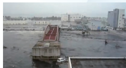
津波による冠水
