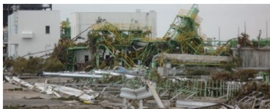
津波波力による破壊
