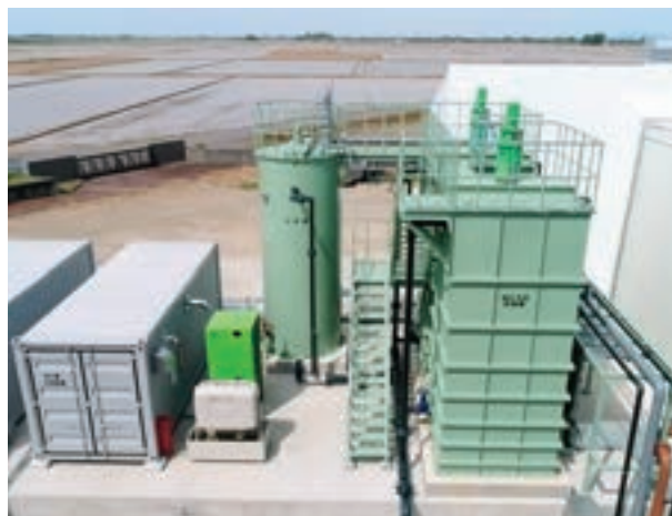
高濃度メタン発酵技術実証プラント コンパクト型バイオガス発電施設
