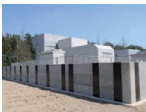
防水壁の設置による施設耐水化 (国交省HPより)
