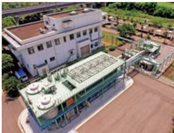
DHS式下水処理施設（高知県須崎市） 電力使用量を大幅に削減した下水処理
