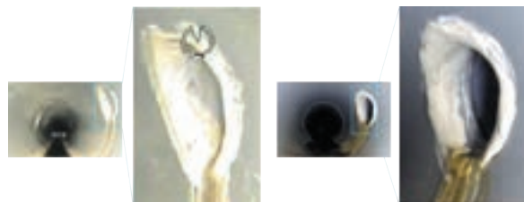
テレビカメラ車とAir Slider®の画像比較 (左：テレビカメラ車、右：AirSlider®)
