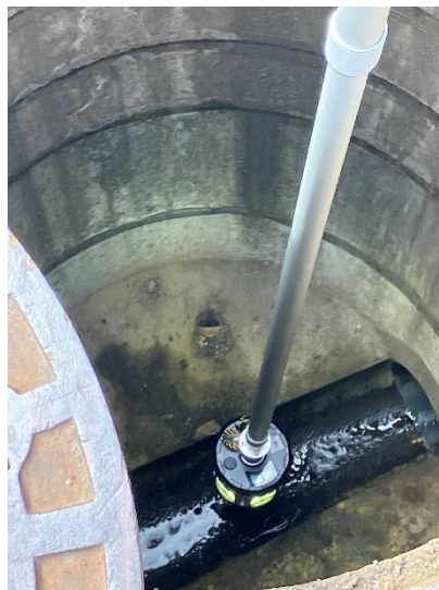
360 度カメラでマンホールを調査
