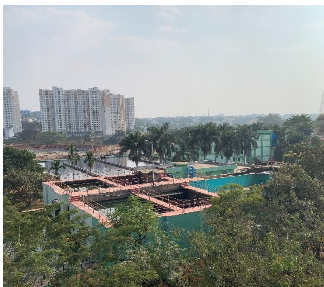
バンガロールの都市と既設浄水場
