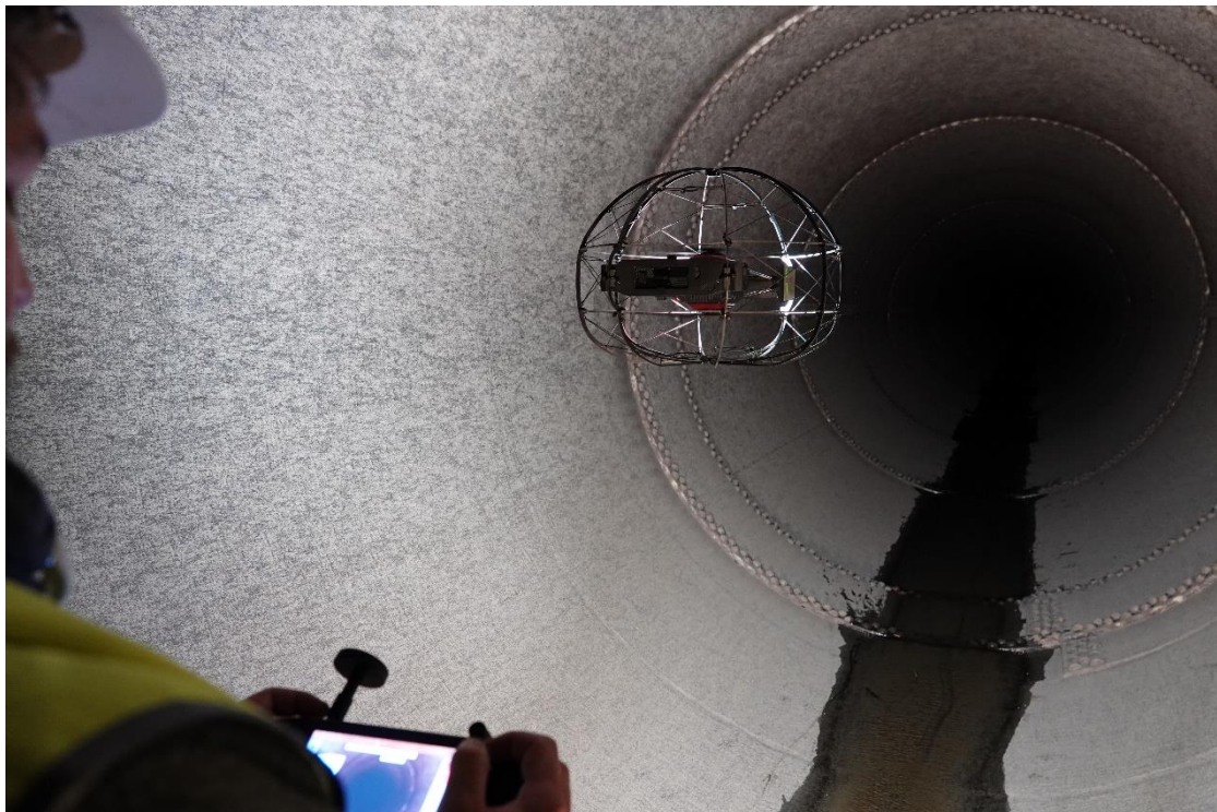
管路施設内を安全に効率よく点検調査
