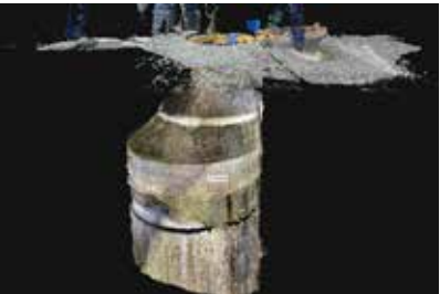
被災したマンホールの3次元データ
