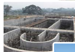
施工状況 下水処理場
