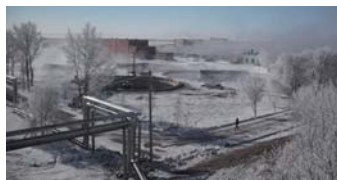
カザフスタン国アстана市上下水道整備 標準活性汚泥法、計画処理水量=136,000m 2 /日 建設2006~2011
