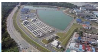
マレーシア国スランガニル下水処理場 Oxidation Ditch法、計画処理水量=37,000m 2 /日 建設2000~2010
