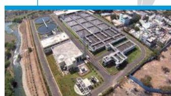
インド国ハイデラバード市下水処理場 A2O+砂ろ過法、計画処理水量=30,000m 2 /日 設計・建設2007~2013
