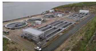
パプアニューギニア国ポートモレスビー市 下水道事業整備事業 Oxidation Ditch法、計画処理水量=25,700m 2 /日(全体) 建設中、2018現在(初のSTEP案件)
