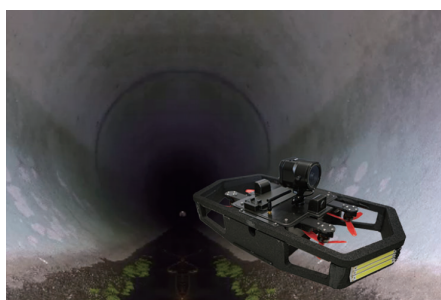
Air Slider (ドローン) を活用した管路劣化診断
