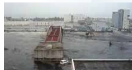
津波による冠水
