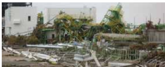
津波波力による破壊
