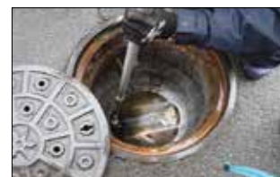
最新のカメラ管路調査
